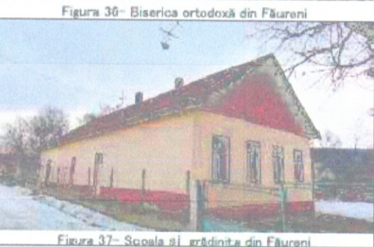
Fosta școală și grădiniță din Făureni.
